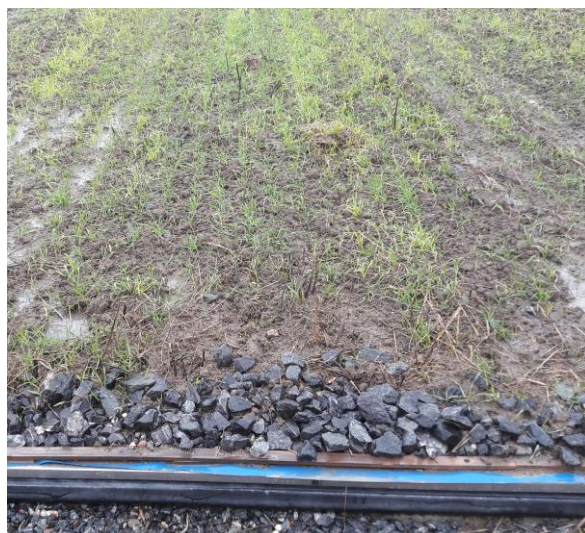
Figur 1.3. Restaurering av oppsamling for overflatevann. Et smalt oppsamlingsområde for overflatevann reduserer fortynning direkte fra regnvann. Redusert risiko for jordrotter i grus og med dyrking helt frem til grusen. Høsten 2020.
