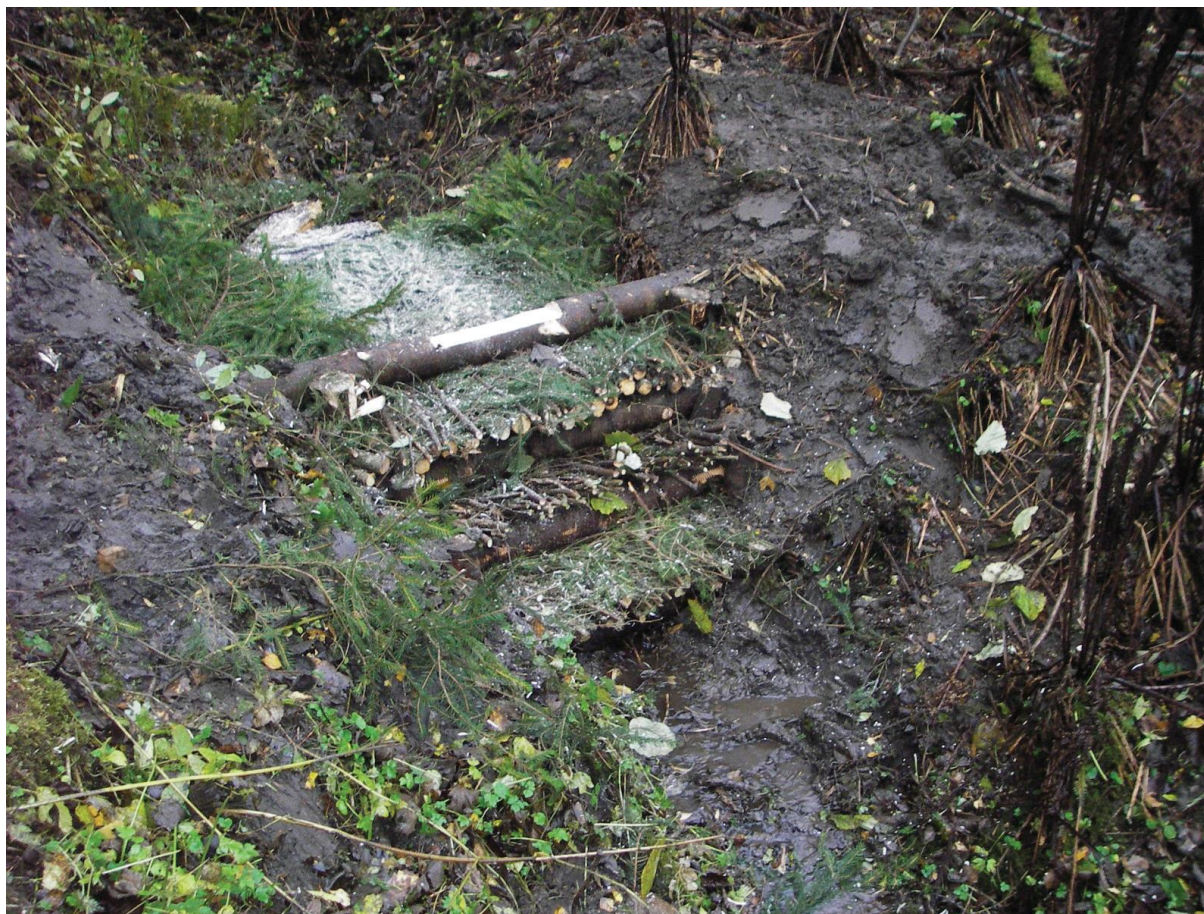
Figur 8: Eksempel på enkel kvistdam for å bremse vann i kanal ved flom
